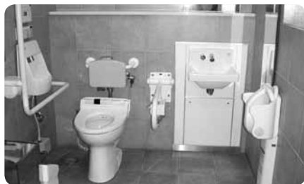
10階のトイレはユニバーサルシートを設置し、オストメイトにも対応
